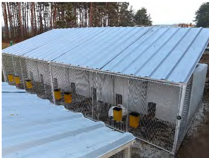
Fot. 5. Zadaszone betonowe domki z wybiegami
