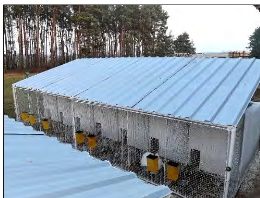
Fot. 1. Kojce betonowe na wolnym powietrzu
