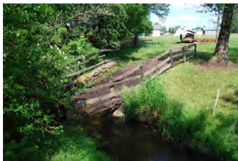
Fot. 5. W ujęciu wody bezpośrednio z rzeki specjalnie wygrodzono i zabezpieczono skarpy
