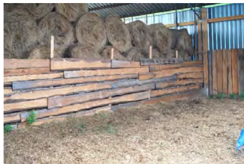
Fot. 2. Obora półotwarta wykonana w lekkiej konstrukcji drewnianej
