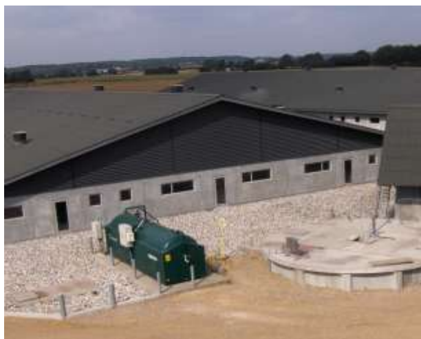
Fot. 6. Zbiornik z kwasem na zewnątrz budynku do zakwaszania gnojowicy „in house“ (fot. JH Agro)
