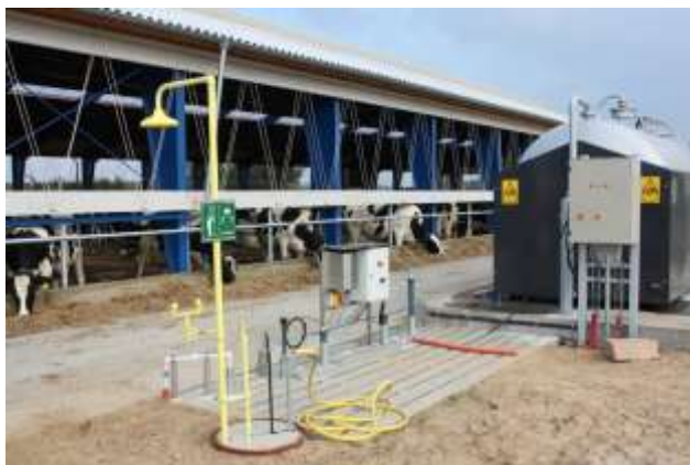
Fot. 5. Instalacja do zakwaszania gnojowicy w budynku inwentarskim (fot. JH Agro)
