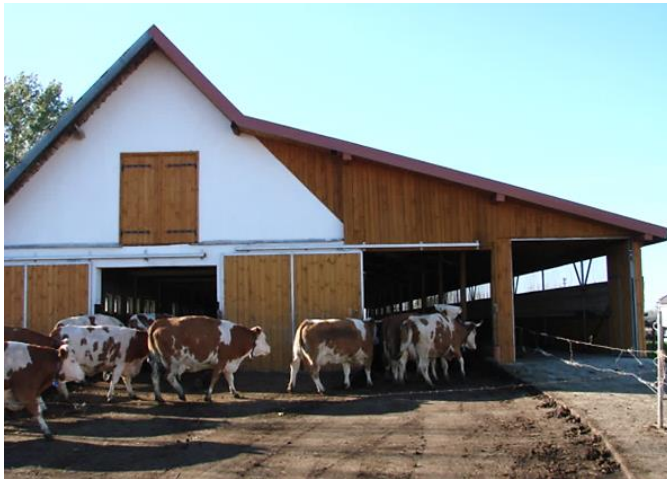
Fot. 3. Przebudowa obory uwięziowej na wolnostanowiskową boksową w ZD IZ PIB Odrzechowa Sp. z o.o. Dobudowane zostały korytarz karmowo-gnojowy oraz stół paszowy (fot. A. Kaczor)
