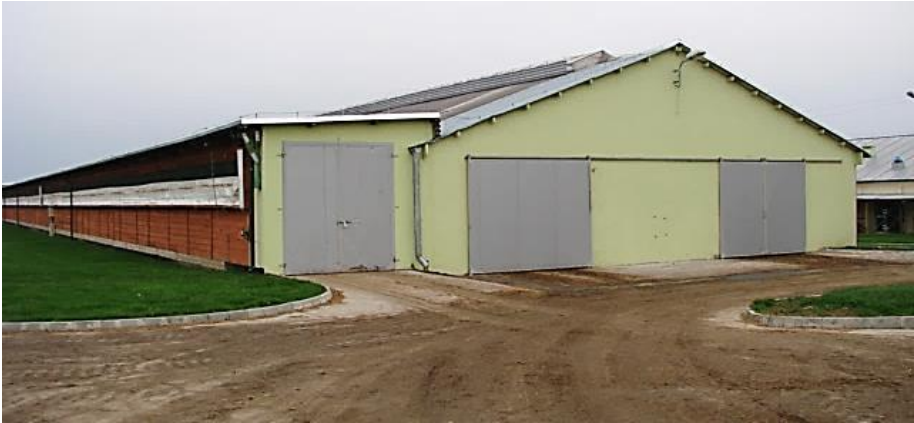
Fot. 4. Przebudowa obory uwięziowej na wolnostanowiskową boksową. Dobudowa stołu paszowego. ZD IZ PIB Kołbacz Sp. z o.o. (fot. A. Kaczor)
