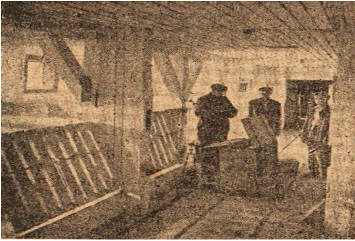
Fot. 4. Wnętrze chlewni kontrolnej w Chorzelowie (archiwum własne ZHTCh)
