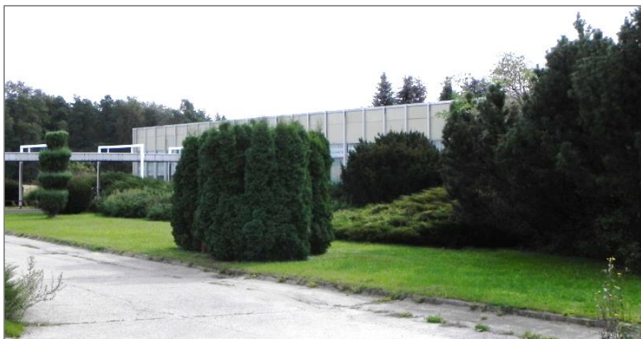
Fot. 1. Centralny Ośrodek Hybrydyzacji w Pawłowicach (fot. M. Kamyczek)
