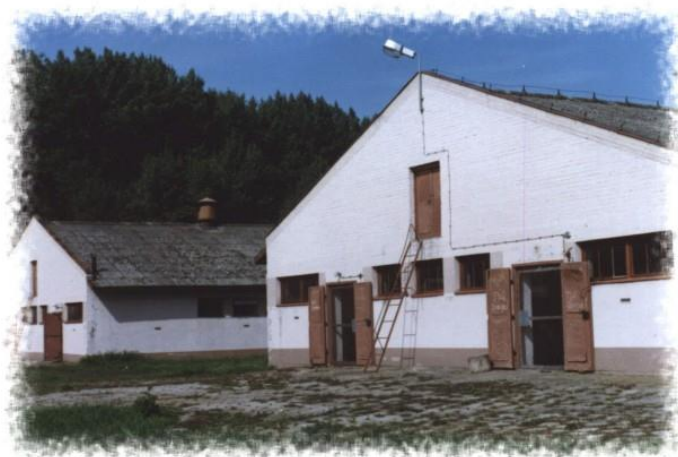
Fot. 8. Budynki stacji kontroli w Pawłowicach (archiwum własne ZHTCh)
