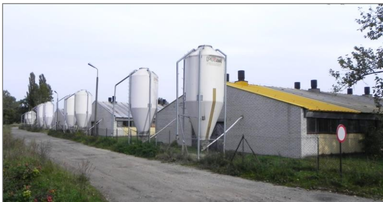
Fot. 2. Chlewnie Centralnego Ośrodka Hybrydyzacji w Pawłowicach (fot. M. Kamyczek)
