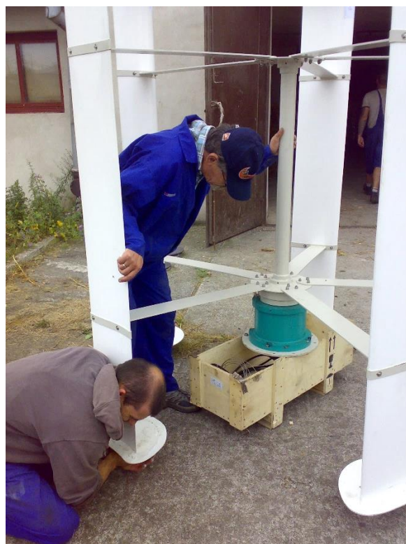
Fot. 36. Montaż wiatrowego generatora wertykalnego, od lewej: dr Tomasz Pająk i inż. Piotr Radecki. XD IZ PIB Żerniki Sp. z o.o. (fot. J. Walczak)
