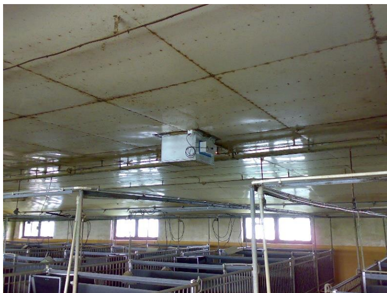
Fot. 44. Prototypowy fotojonizacyjny filtr powietrza. ZD IZ PIB Żerniki Sp. z o.o. (fot. J. Walczak)
